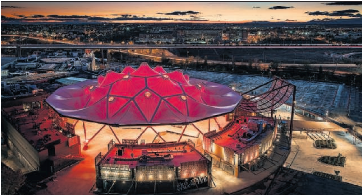
Vista del nuevo centro comercial X-Madrid, en Alcorcón. / HÉCTOR GÓMEZ RIOJA
